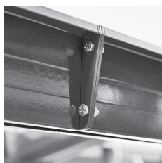
Pfettenverschraubung Edelstahl Schrauben/Muttern
