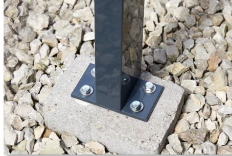
Verbindung Pfosten und Fuß auf dem Fundament
