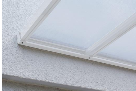
Verbindung Mittel- und Randsprossen am Wandhalterprofil mit Edelstahlschrauben
