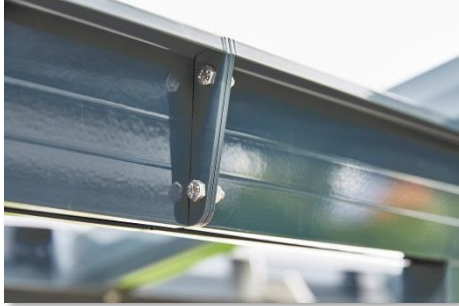
Verbindung Querträger bei Breite 4,26m und 5,46m mit Edelstahlschrauben
