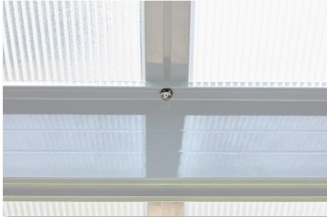
Verbindung Mittel- und Randsprossen an den Querträger mit Edelstahlschrauben
