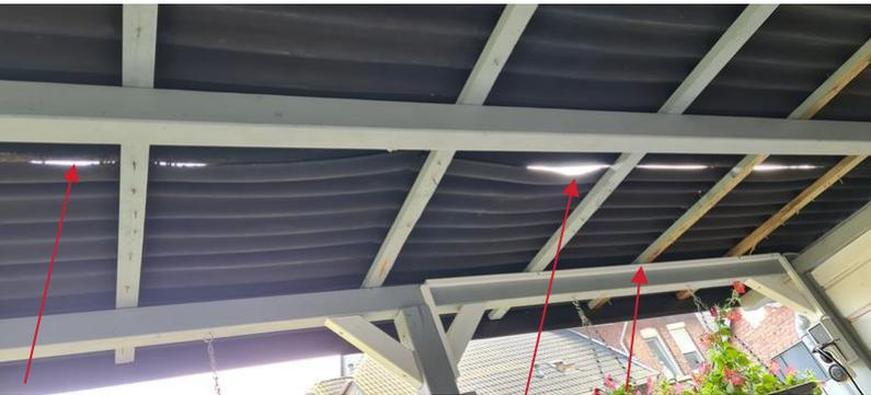
Bohrlöcher nicht vorgebohrt -> dadurch können sich aufgrund des zu kleinen Bohrloches die Platten nicht „frei“ bewegen = Entstehung der Wellen!
